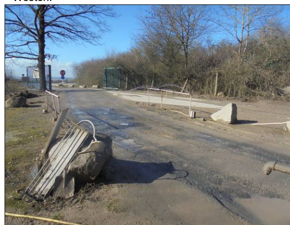
Abb. 4: Ausfahrt vom Gelände der Recyclingbauschuttanlage, Blick nach Süden.
