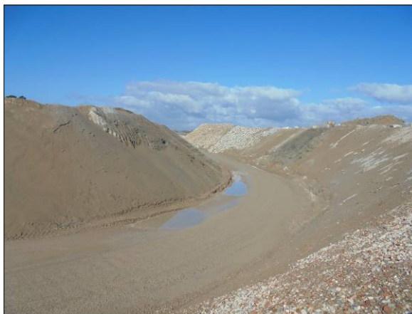
Abb. 6: Gelände der Recyclinganlage, Blick nach Westen.
