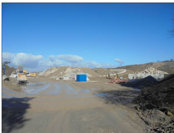
Abb. 3: Einfahrt auf das Gelände der Recyclingbauschuttanlage, Blick nach Westen.
