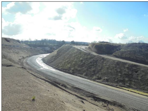
Abb. 8: Ruderal überwachsener Hangbereich, Blick nach Osten.
