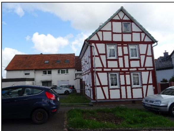
Als Kulturdenkmal nach HDSchG eingetragenes Gebäude, Lahnstraße 19 (Aufnahme 04/2024)
